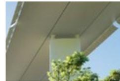
**Carter:** parti laterali della struttura in acciaio del nuovo Viadotto
