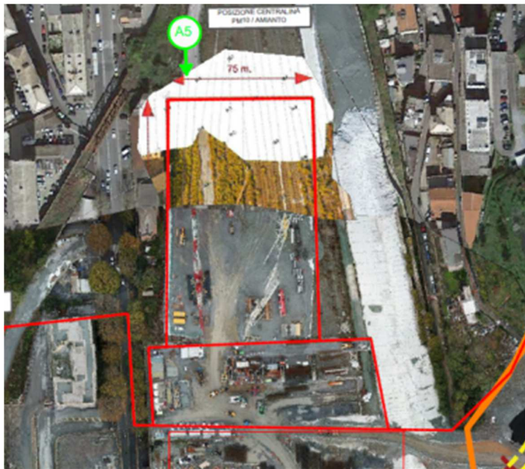
Figura 9 – Postazione levante a Nord (44.25360 N, 8.53322 E) – PPN3 – A5
