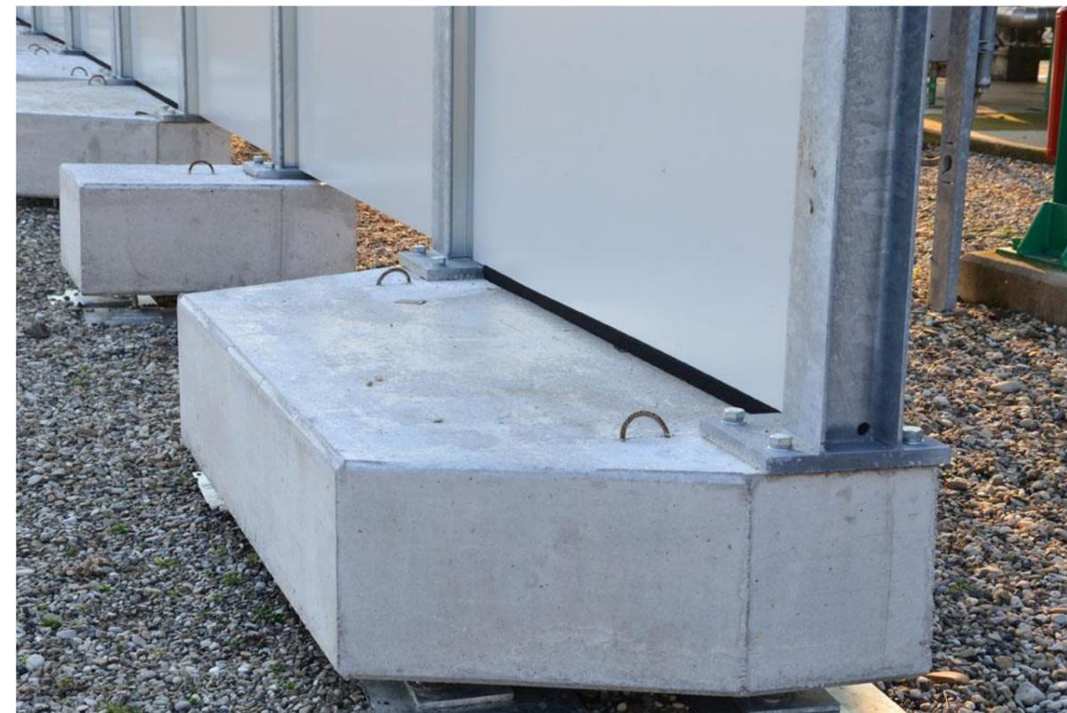
Per le lavorazioni a maggior impatto acustico verranno inoltre utilizzate, ove necessario, barriere fonoisolanti di tipo mobile. Il vantaggio di tali barriere deriva dal fatto che sono composte da moduli singoli autoportanti, costituiti da pannelli fonoisolanti posti su di un basamento che impedisce il ribaltamento del modulo e garantisce uno stabile appoggio a terra senza nessun fissaggio. Hanno altezza variabile fino ad un massimo di 6 metri.
