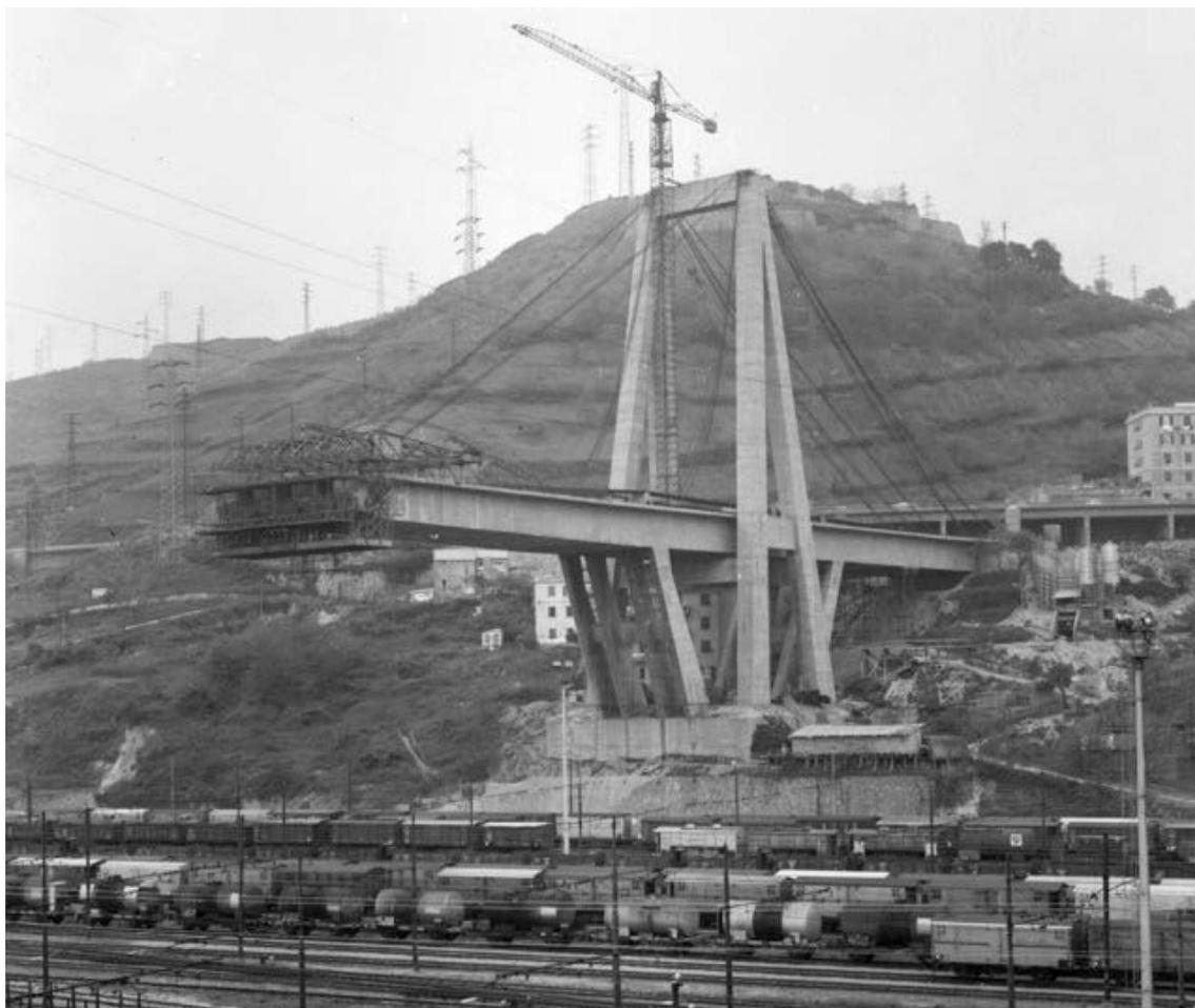
Figura 9.1 – Foto scattata durante la costruzione del viadotto Polcevera, spalla est (anni '60)
