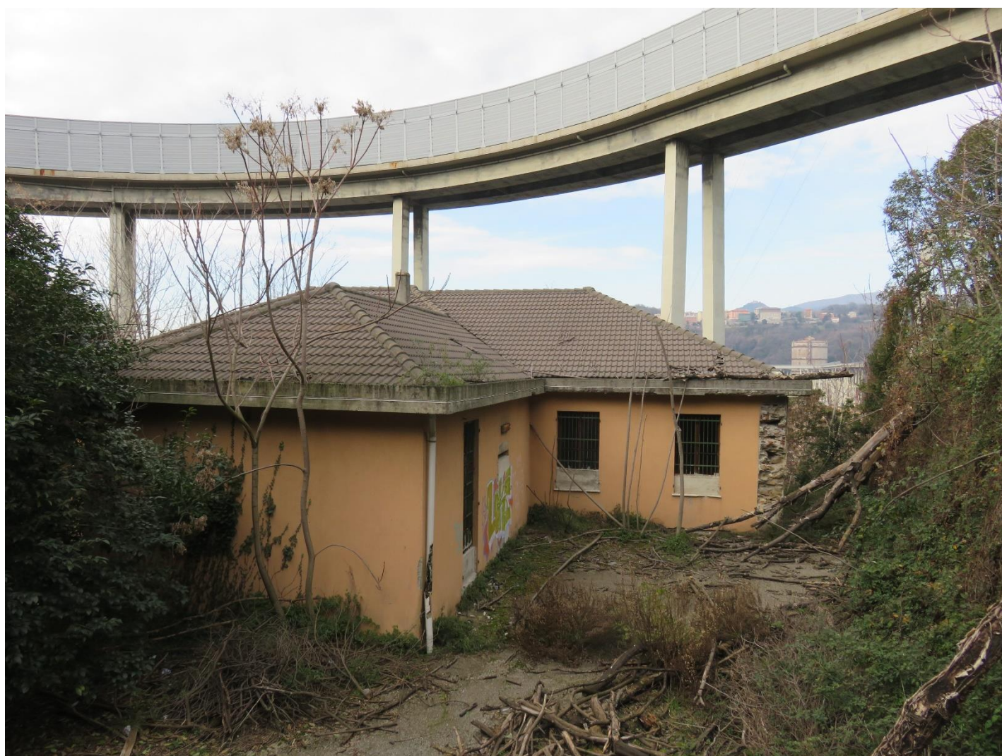
Figura 3.2 – Fabbricato ex-ANAS esistente, Fronte Nord-Est piano primo
