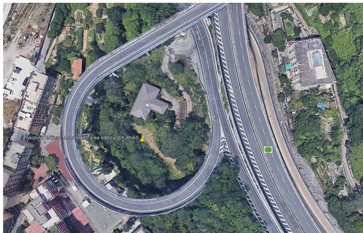
Figura 1.2 – Posizione Edificio Tecnologico
