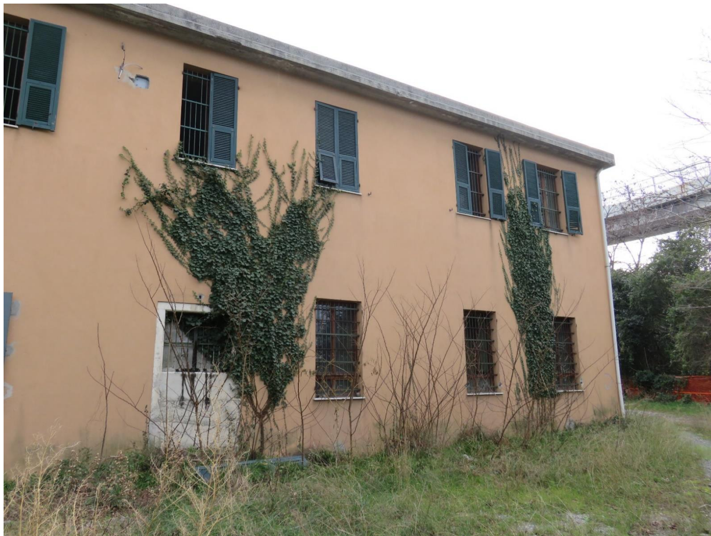
Figura 3.3 – Fabbricato ex-ANAS esistente, Fronte Ovest piano terra e piano primo
