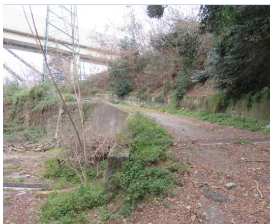
Figura 7-3 – Immagine della viabilità esistente
