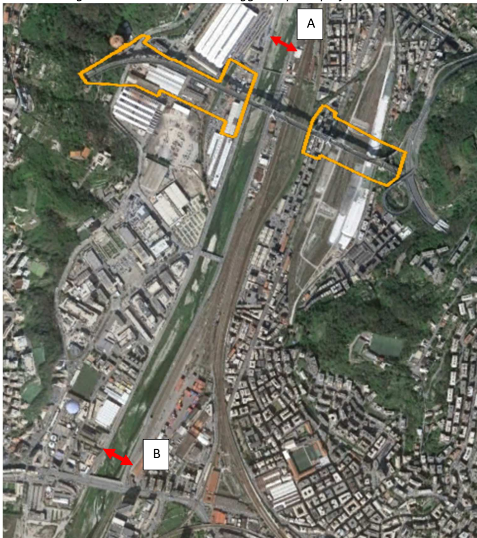
Figura 51: sezioni di monitoraggio acque superficiali
