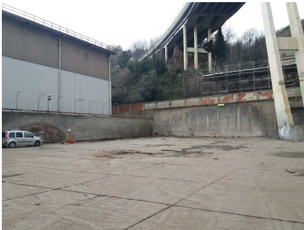
Figura 45: Area Revetro – piazzale esterno- cantiere Ponente– scatto del 31/01/2019
