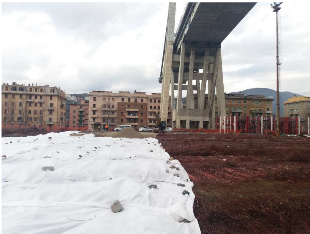
Figura 48: cantiere Levante (scatto del 31/01/2019)
