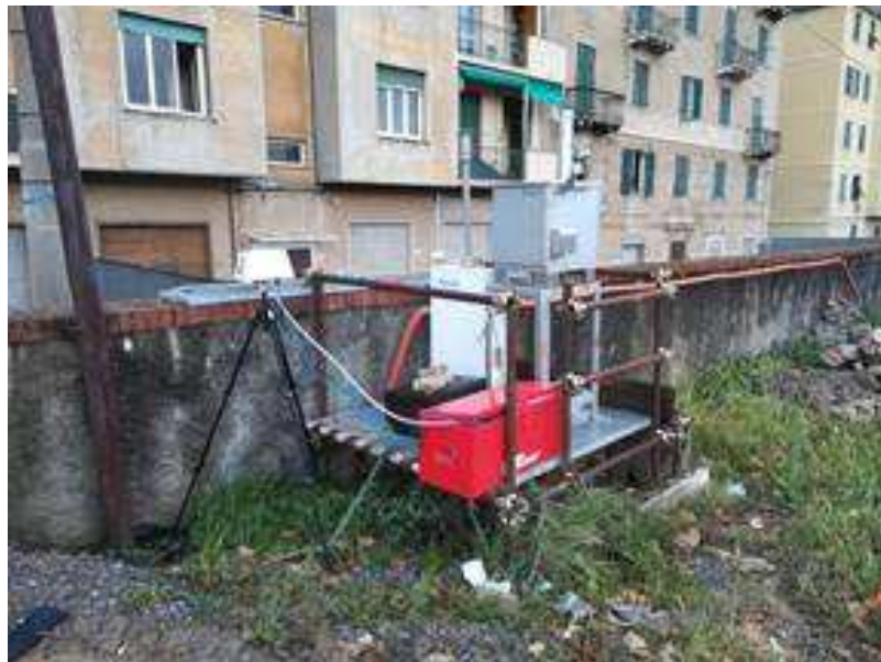
Figura 12 – Centraline Postazione levante a Sud (44.423296 N, 8.892176 E) – PPS3 – A6
