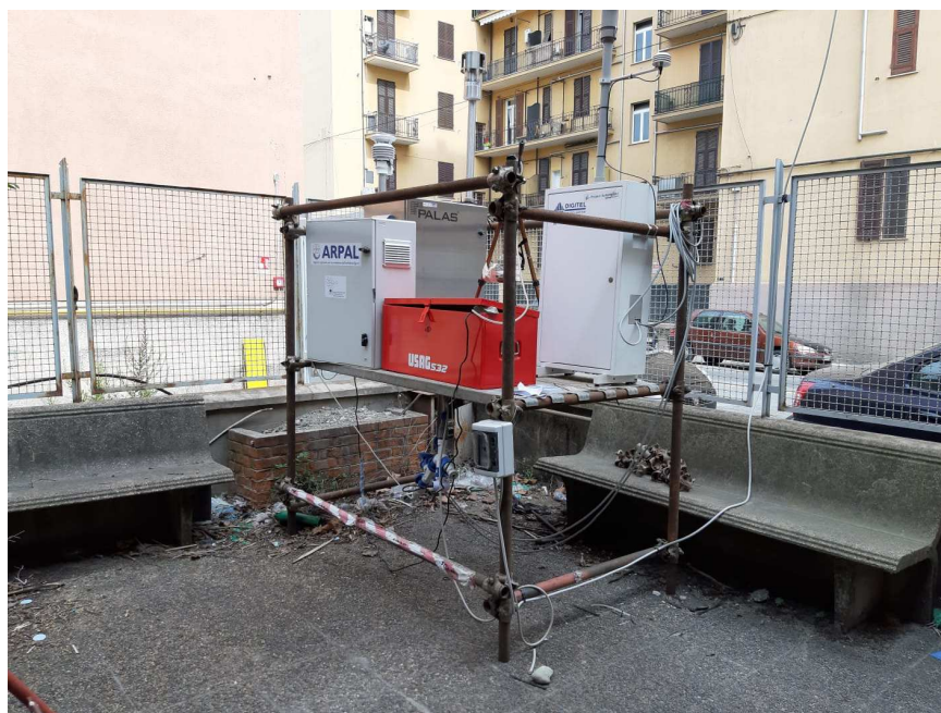
Figura 8 – Centraline Postazione levante a Sud (44.424376 N, 8.889742 E) – PPS2 – A4
