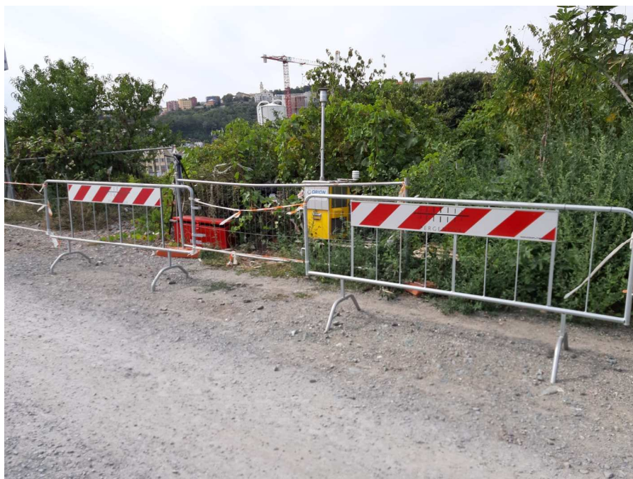
Figura 6 – Centraline Postazione levante a Nord (44.425934 N, 8.890475 E) – PPN2 - A3
